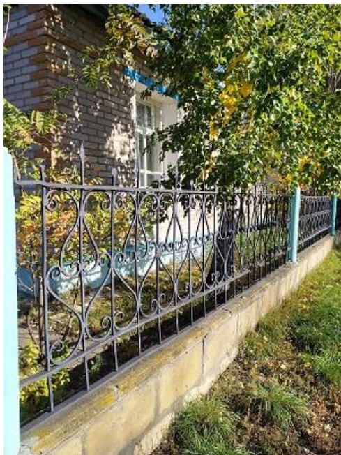
Фото 14 . Часть реставрированной ограды у дома. 2024 год
